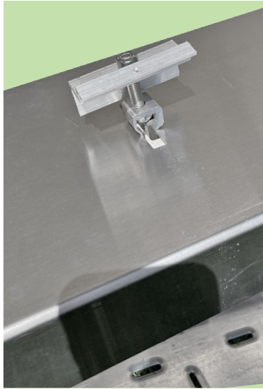
Duraklick-Endklemmen einsetzen, die Nase vom Klemmenfuß zeigt nach oben.
